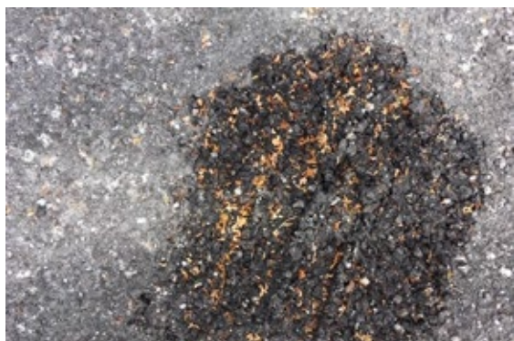
Der Schaden wurde durch auslaufendes Öl verursacht
